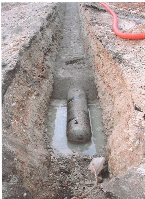
Foto 2 : Testa della tubazione DN 600 mm realizzata – lato Falzè di Piave.
