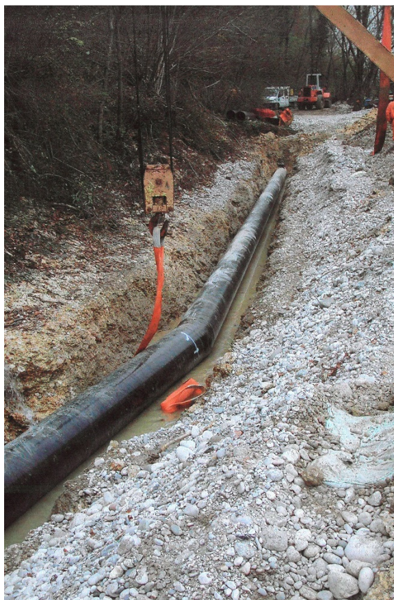
Foto 3 : Tratto finale della tubazione DN 600 mm realizzata – lato Montello.
